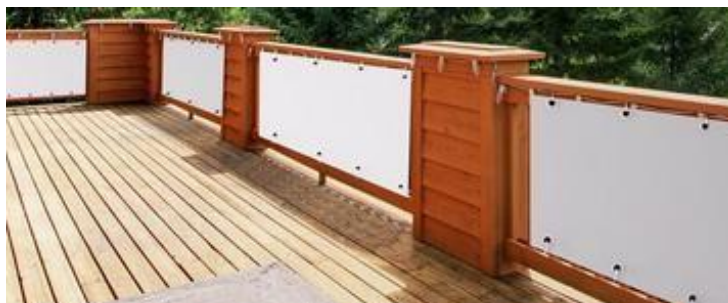
Figura 1 Copertura del balcone
