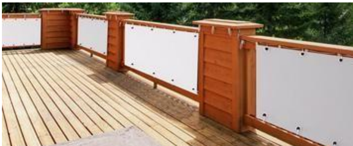
Figura 1 Copertura del balcone
