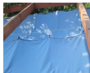
Rysunek 1c. Partie supérieure de la voile ouvrante sur 3 fils
