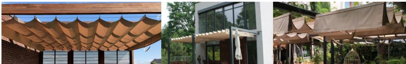
Figura 1: Persiana romana a) sobre estructura de madera b) sobre travesaños de acero c) sobre estructura metálica
