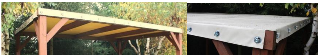
Figura 1: Techo de vela
