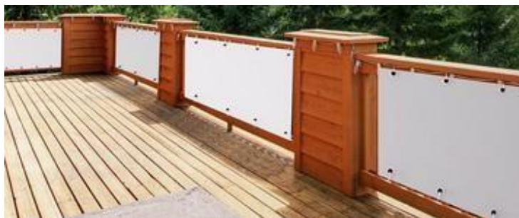
Figura 1 Cubierta del balcón
