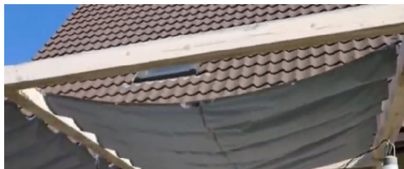
Abb. 1b. Aufrollbare Sonnensegel auf 2 Seilen
