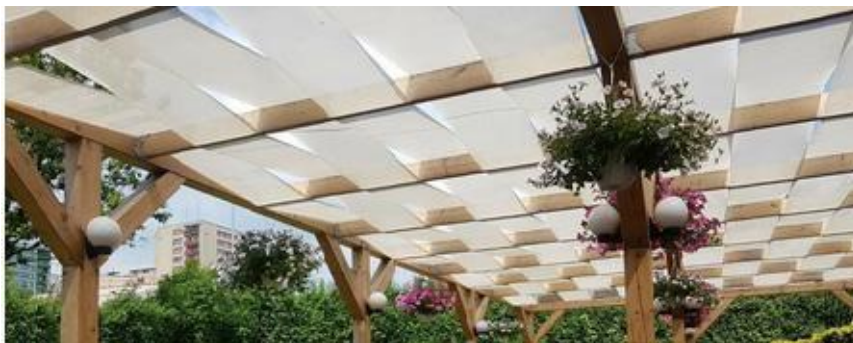
Obrázek 1: Arboristické pásy na konstrukci.
